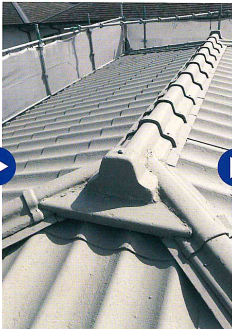
《ティーアールフィラーα 施工後》
